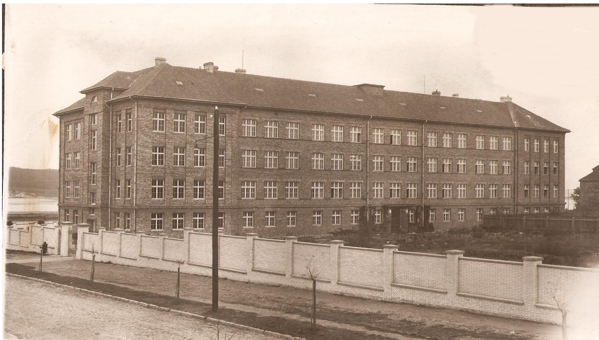
Fotografia 8. Budynek LMK przy ul. Bechiego 1 w latach 30. XX w., widok od ul. S. Bechiego
