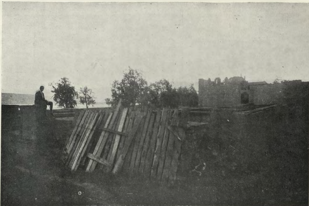
Stan budowy Gimnazjum im. M. Konopnickiej w początkach sierpnia 1928 r. http://rcin.org.pl
